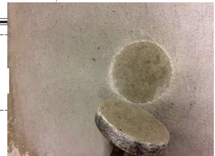
Pente test no 1
